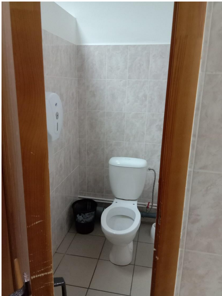
Санузел 28 (кабина) Фото 5.6
